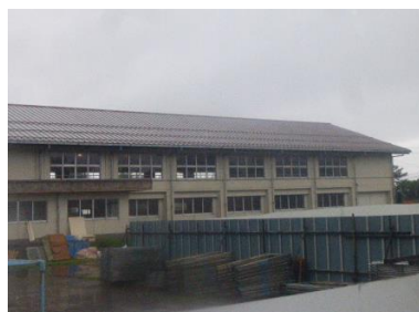
体育館の屋根修理
