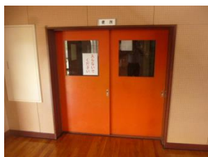
体育館トイレ
